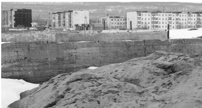
Рис. 1. Открытое хранение твердой фракции в двухстах метрах от стен жилых домов
